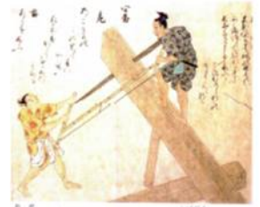
大鋸を引いて板を切り出す職人
