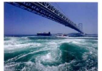
うず潮と大鳴門橋
